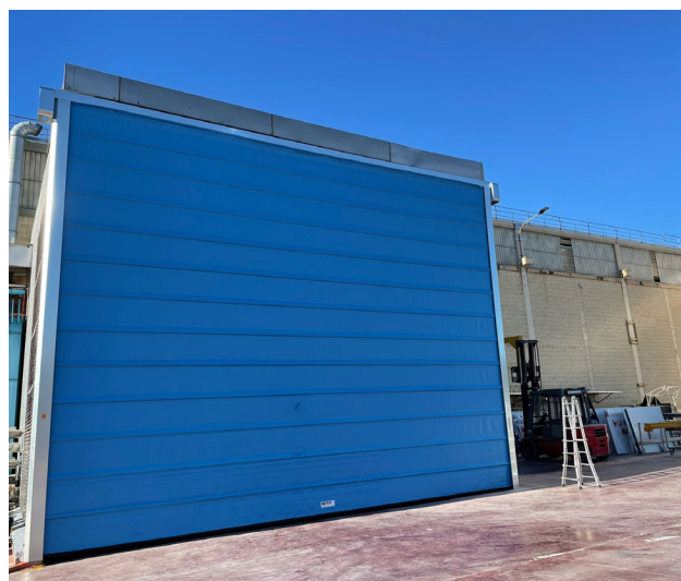
installazioni speciali di grandi dimensioni
